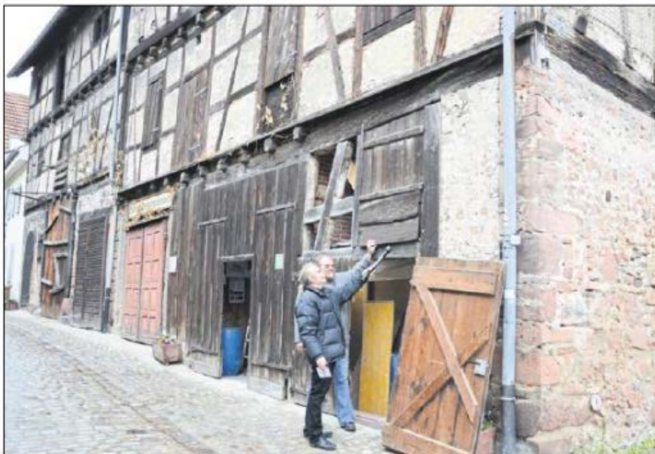
BERND WIELAND UND BERND SÄUBERT begutachten den Torrückbau. Der Einbau diverser, in den 50er Jahren als Garagen genutzten Tore, trägt zur Instabilität der Außenfassade bei. Foto: Dürr
